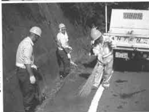
▶ なんてん共働サービス。作業中
