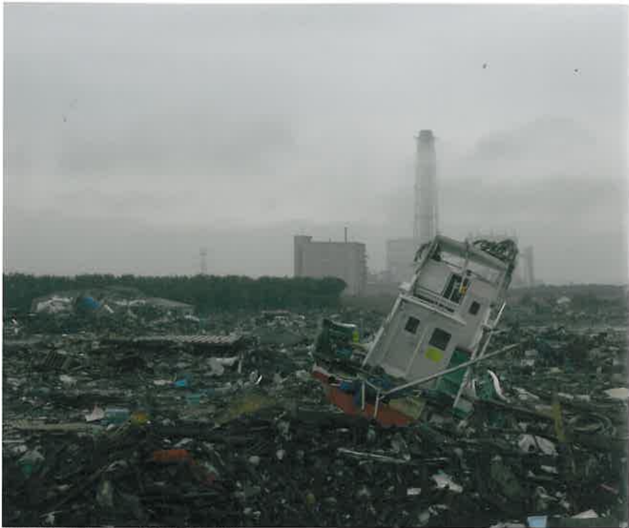
▲津波被害で停止している相馬火力発電所周辺
